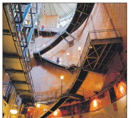
Bau von historischem Wert: Blick vom Tunnelgrund auf die Nordkuppel, Treppen und Fahrkörbe. Zeitweise gab es hier sogar eine Rolltreppe. Foto HPA
